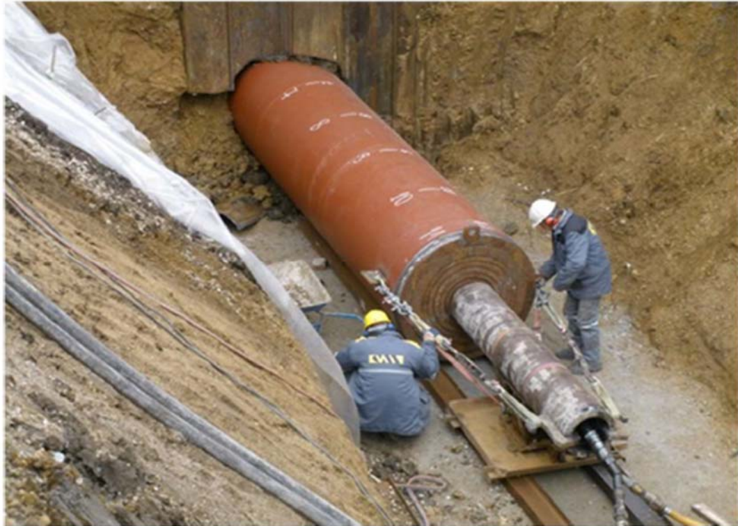
Фигура 25. Изпълнение на хоризонтален сондаж чрез пневматичен чул
