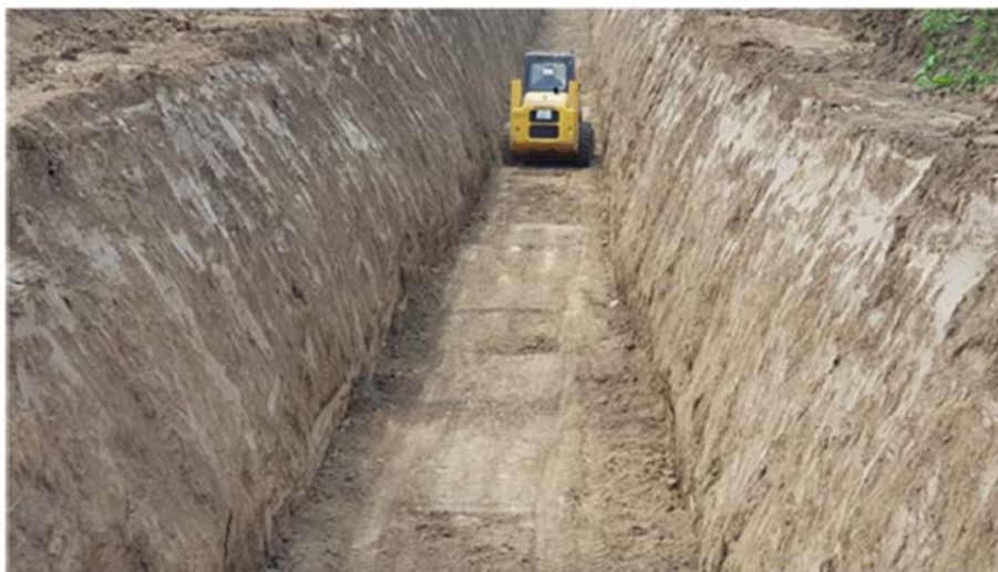
Фигура 17. Подравняване на дъното на траншеята
