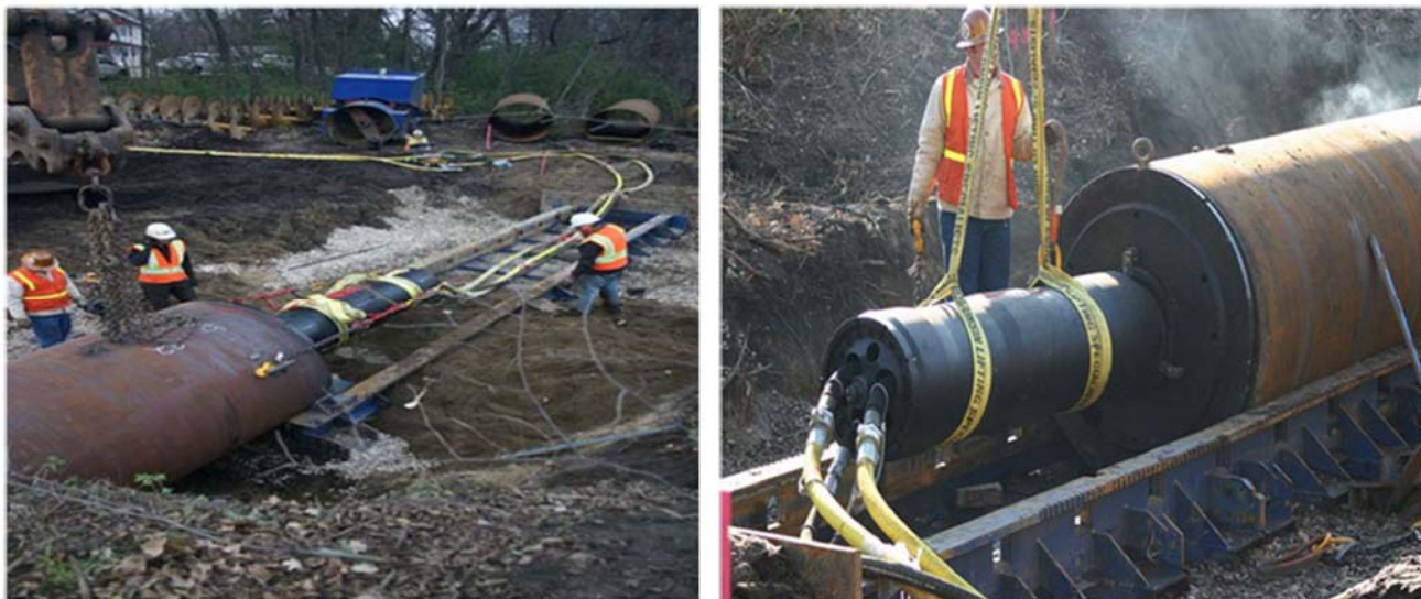
Фигура 23. Набиване с пневматичен чук
